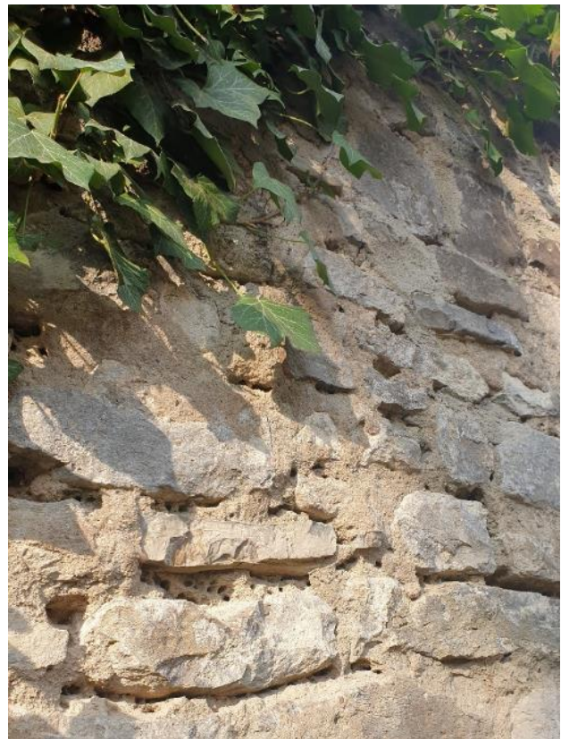
Bild 1: Die alte efeubewachsene Steinmauer mit ihrem hohen Sandanteil im Putz bietet Wildbienen optimale Nistbedingungen. In den breiten Fugen sind die Nistgänge zu erkennen.
