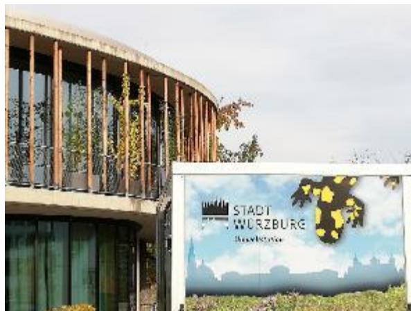
Bild 11: Neubauten müssen angemessen begrünt werden, hier wurden Kletterpflanzen in Containern vorgesehen; eine bodengebundene Begrünung ist in jedem Fall die bessere Wahl.
