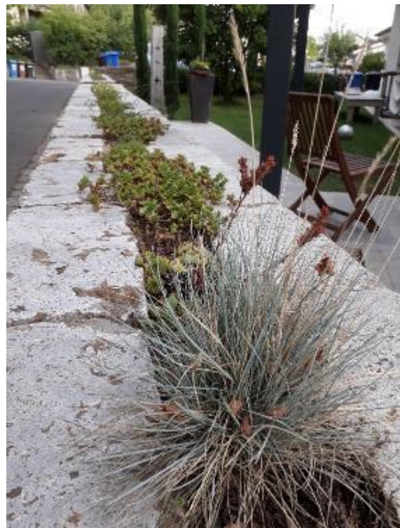
Bild 4: Eine offene Mauerkrone mag nicht normengerecht sein, sie stellt jedoch einen ökologischen Mehrwert gerade bei den neuerdings geklebten Fertigmauersystemen dar. (Bildautor: © Theresa Edelmann, LWG)
