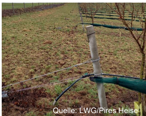
Bild 2: Verankerung der Spanndrahte
